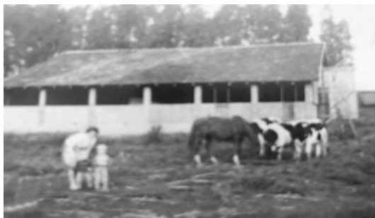
Betsie, Adriano e Afonso com um galpão novo que nós construímos ao fundo.
